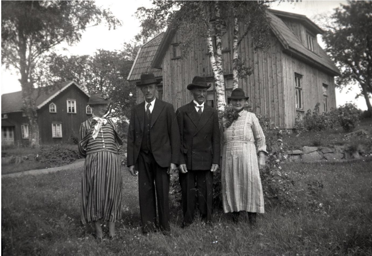
Bild 16: Från vänster, Anna och Karl, Levin och Anna. "Gamlastuva", till vänster, stod ungefär där garaget står idag (2023). Den revs någon gång på 1950-talet. Nuvarande hus, till höger, byggdes som undantag av Olof Håkansson och Gustava Larsdotter och har byggts till i omgångar under årens lopp och ser tämligen annorlunda ut idag. De bodde dock aldrig där, Levin och Anna flyttade i stället in här när de gifte sig.
